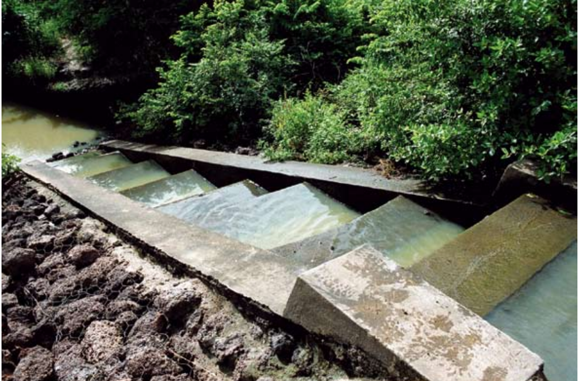
صورة ٢-٣: تتيح ممرات الأسماك هجرة الأسماك إلى خارج سد الري (بوركيننا فاسو)، وهي تعتبر تحسیناً على البنية التحتية يمكن أن يترافق مع تصريفات الجريان البيئي.
